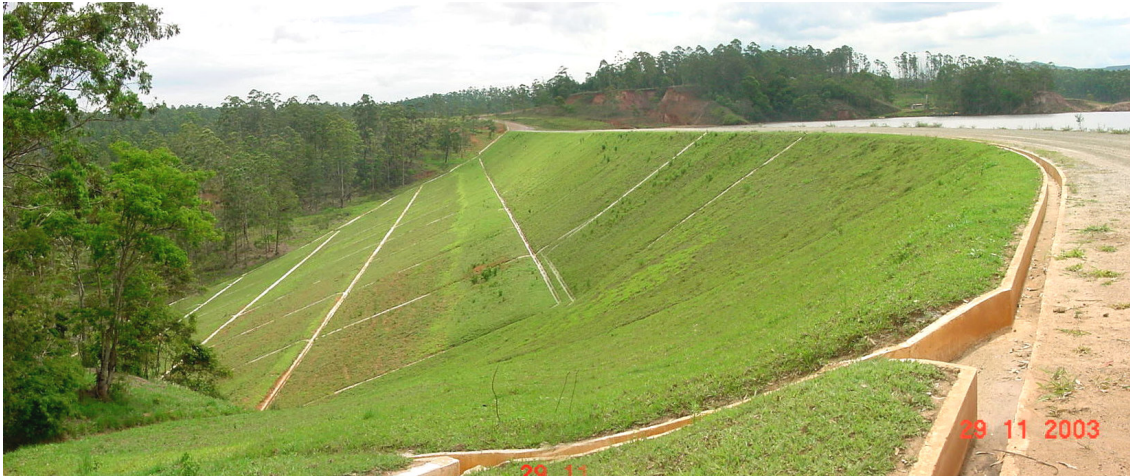
Figura 4.11 – Vista lateral da Barragem do Pontal
