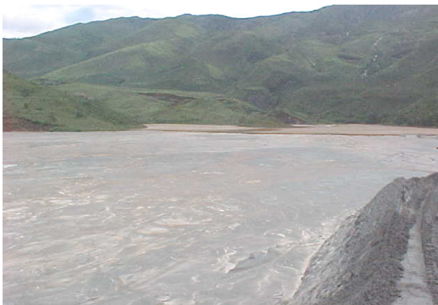
Figura 4.5 – Vista parcial do reservatório da Barragem do Doutor
