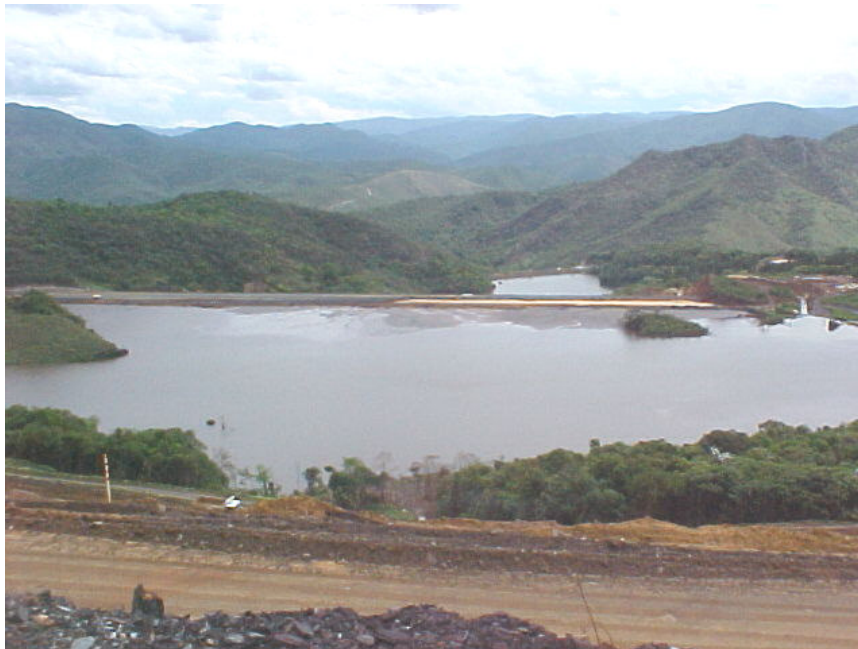
Figura 4.8 – Vista do reservatório 1 da Barragem de Gongo Soco
