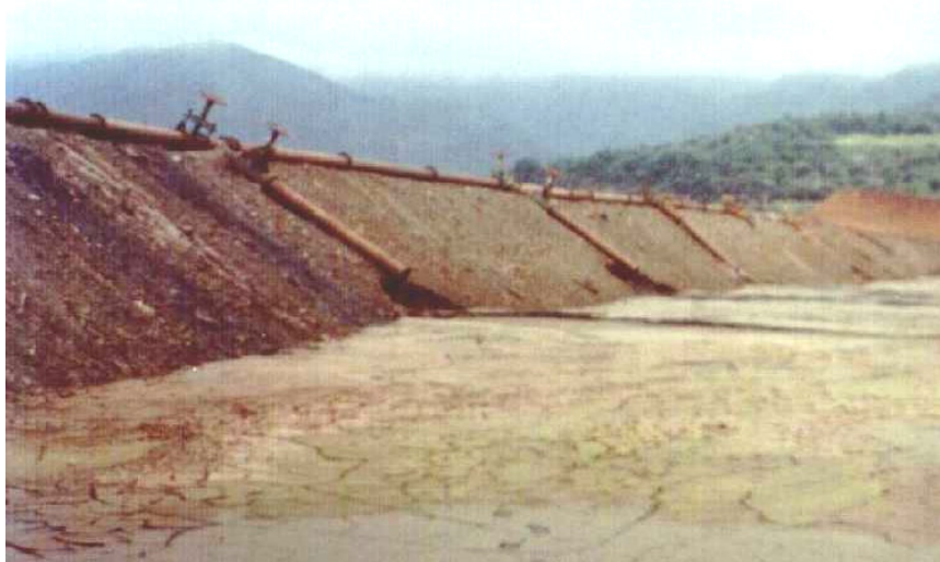
Figura 4.9 – Vista do dique principal e praia de disposição da Barragem de Gongo Soco
